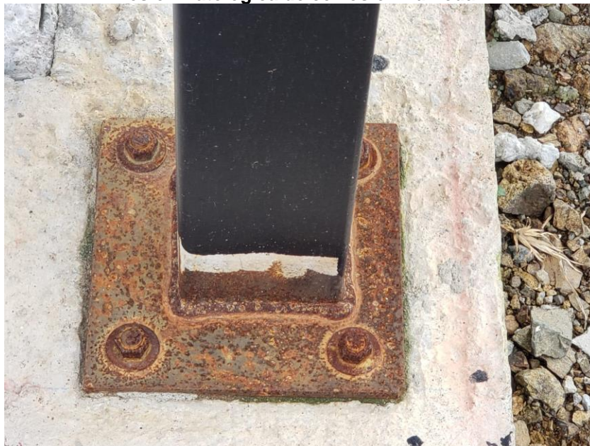
Imagen 20. Foto Evidencia Lesión Patológica de corrosión húmeda
