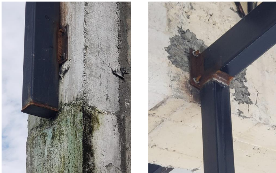
Imagen 20. Foto Evidencia Lesión Patológica de corrosión húmeda
